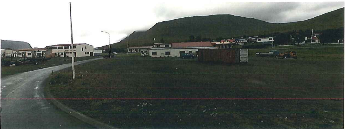
Mynd 1.2 Strandgata 39 (A4) til vinstri og Strandgata 37 (A5) til hægri. Óbyggðar lóðir Strandgata 29 (I4) til hægri og Strandgata 31 (A5) í forgrunni (já.is, 2014).
