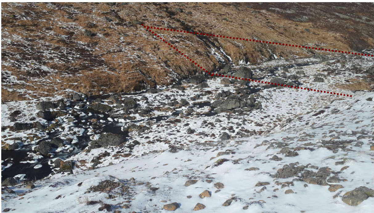
Mynd 4.4 Stíflustæði, yfirfall fyrirhugað á vinstri bakka árinna (Mynd:ÞSL).
