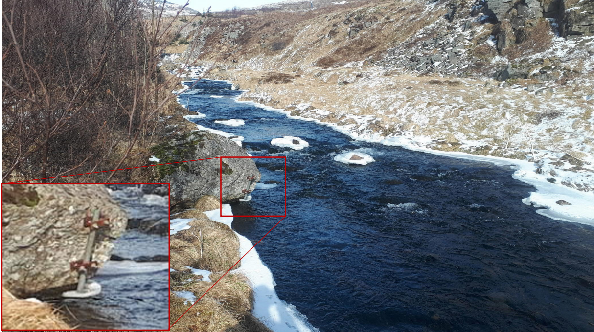
Mynd 3.4 Vatnshæðarmælistaður í Hólsá skammt ofan göngubrúar á móts við Túngötu. Þrýstiskynjarinn er neðan vatnsborðs inni í rörinu sem sjá má á innfelldu myndinni.
